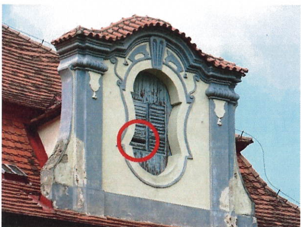
č. 32 - 35 Detaily vletových otvorů do podšřeší ve vikýřových oknech, jihovýchodní fasáda
