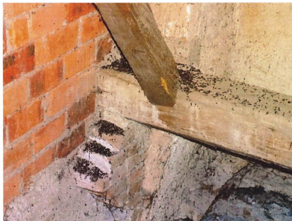
č. 23 - 25 Podstřeší, trus netopýrů na podlaze půdy a konstrukčních prvcích krovu
