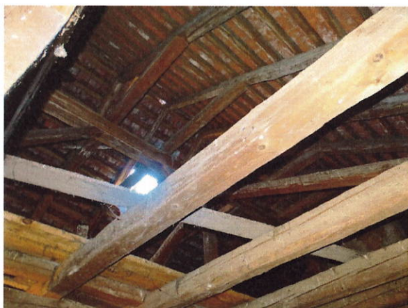
č. 20 Podstřeší, detail konstrukce krovu
